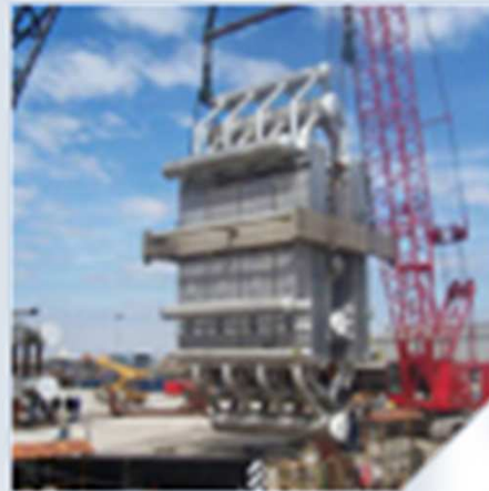
Gelötete Aluminium Wärmetauscher
